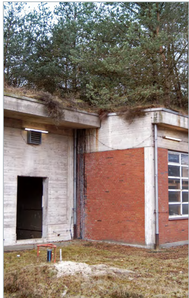
Wärme-/Kälte-Haus: Tri-Schaden nach Havarie
