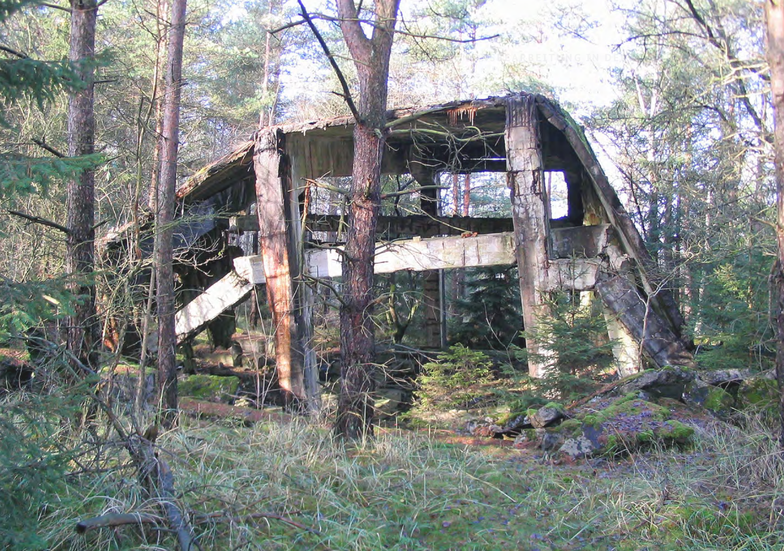
TrübPI Munster-Nord, Altanlagen der Heeresversuchsanstalt „Raubkammer“: Bereich R VIII (2012)
