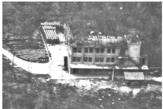
Schmelz-, Misch- und Gießhaus (SMG) der Füllgruppe I (Gebäude 3048)
